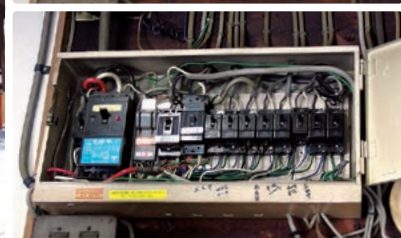
新たに機器を搭載した電灯分電盤を設置（社務所） 写真は改修前の分電盤
