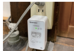
庫裡のコンセントに設置
